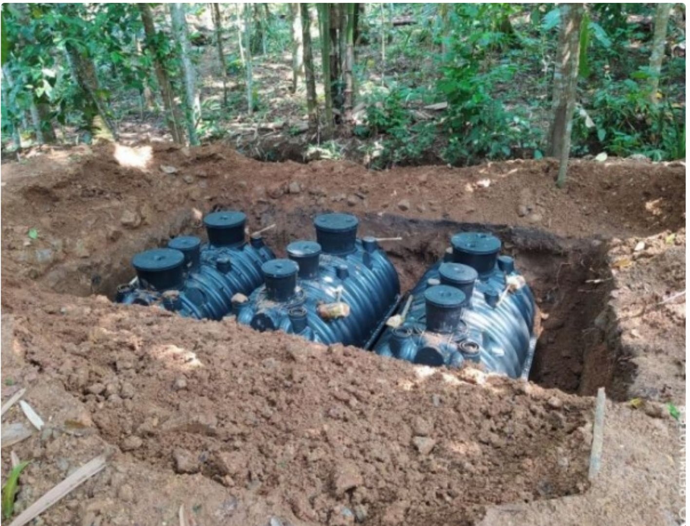
Pemasangan Septic tank pada program IPAL Komunal
